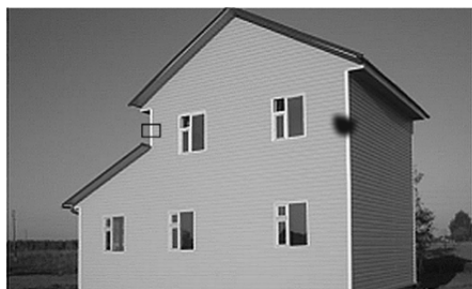
Рис. 2. Изображение дома с дефектной областью
